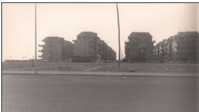
Le palazzine Armellini di Nuova Ostia, dove furono trasferiti gli abitanti dell'Acquedotto Felice. Archivio Coord.Citt. Nuova Ostia , anni Ottanta.
