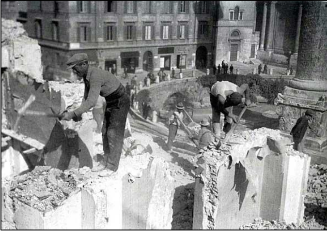
La demolizione della collina Velia ai Fori Imperiali, anni Trenta.
