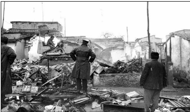
La demolizione del borghetto latino negli anni Sessanta.
