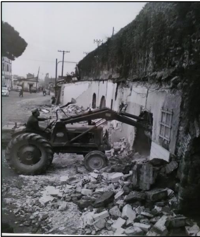
Demolizioni all'Acquedotto, 1973. Foto Rodrigo Pais.
