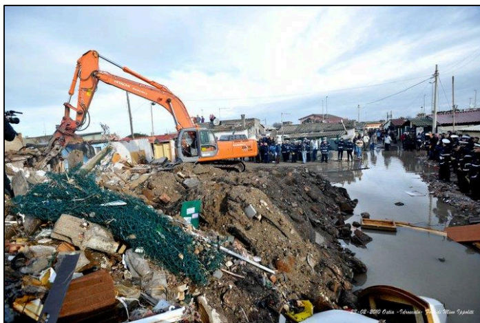
Demolizioni all'Idroscalo, 2010. Foto: Mino Ippoliti.
